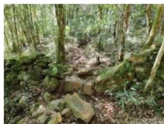
Figura 7.199. Estrutura colapsada do mangueiro de taipa de pedra. UTM 22J 500157/6957530. Foto e Acervo: Scientia, 2025.
