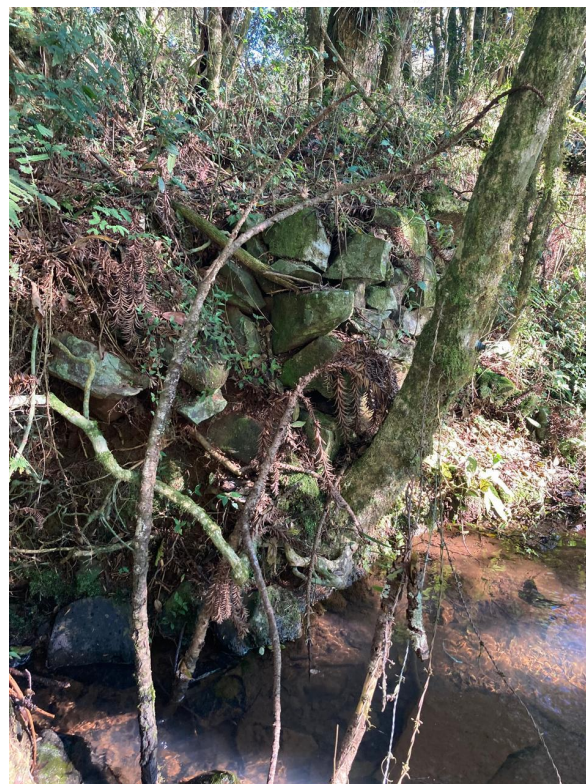
Figure 128. A imagem mostra uma construção de Taipas, localizadas no município de Rio das Antas. SC. BR. Na propriedade do senhor Ivo Dietrich Breyer. Nesse local, é possível identificar, além das construções entaipadas, a construções de terraços e casas subterrâneas.
