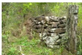
Figura 4.86. Perfil do encaixe das pedras na Taipa de Pedra nº 56, P03. Foto e Acervo: Scientia, 2018. Fonte: (HERBERTS A. L., 2021).
