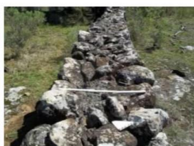
Figura 4.84. Detalhe do encaixe das pedras no interior da Taipa de Pedra nº 20, P05. Foto e Acervo: Scientia, 2018. Fonte: (HERBERTS A. L., 2021).
