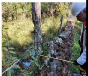
Figura 7.198. Medição da largura do muro de taipa de pedra. UTM 22J 500152/6957551. Foto e Acervo: Scientia, 2025.
