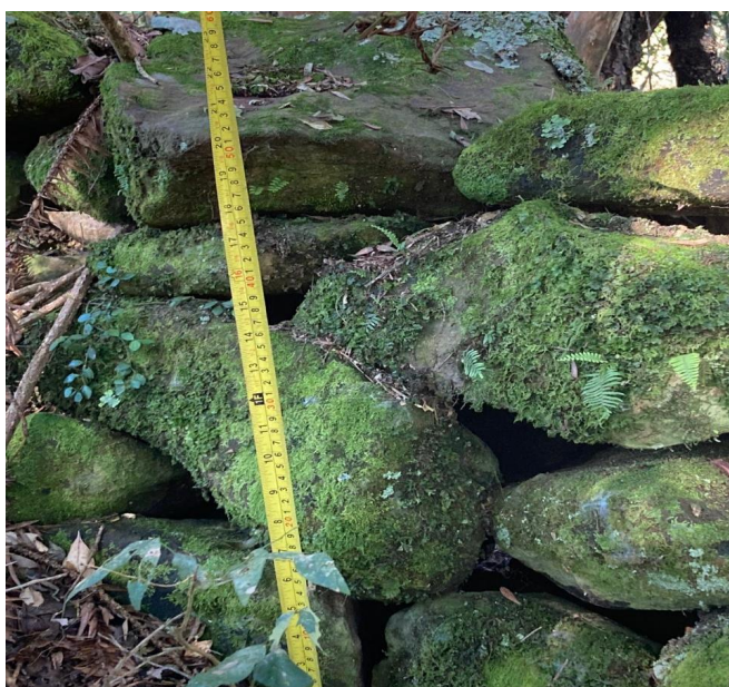
Figure 33. As áreas entaipadas apresentam uma altura de 1 metro e 20 centímetros, onde não sofreram a ação humana na atualidade. A largura de 40 centímetros representa uma construção bastante sólida, que resistiu por muitos milênios.
